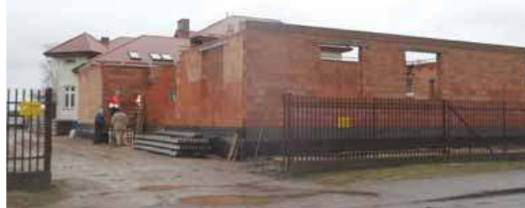
Rozbudowa obiektu SP w Dzierzgowie
