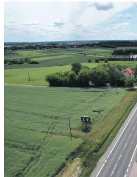
DK9 z drogą ekspresową S74 w Opatowie. To kluczowy, 15-kilometrowy fragment, który wymaga szybkich decyzji i rozpoczęcia prac projektowych.
