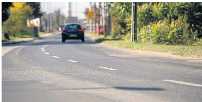
Trzeci odcinek ul. Zakładowej - między Al. Józefiaka a ul. Gajcego - będzie wkrótce remontowany
