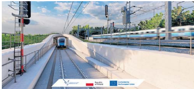
Pod Łodzią Kolej Dużych Prędkości przejdzie tunelem
