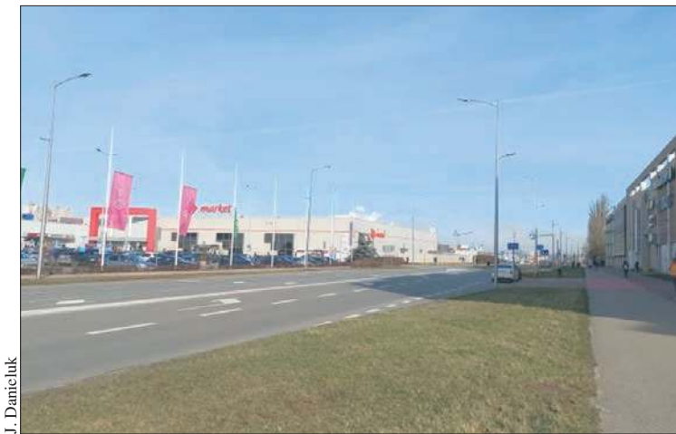
Część ul. Przemysłowej wymaga remontu. Miasto pozyskało na ten cel rządowe dofinansowanie
