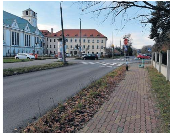
Jest rozwiązanie problemu przejścia trasy średnicowej w rejonie skrzyżowania ulic Grunwaldzkiej i św. Józefa
