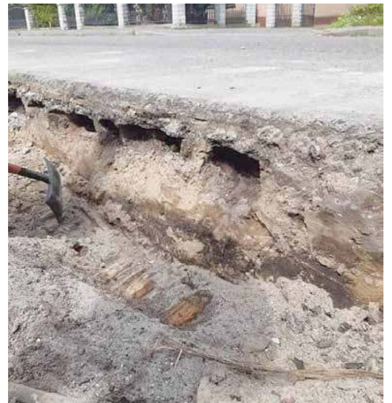
Drewniane wzmocnienia nasypu drogowego, odkryte w lipcu zeszłego roku, okazały się zabytkiem, co wydłuży termin zakończenia całej inwestycji
