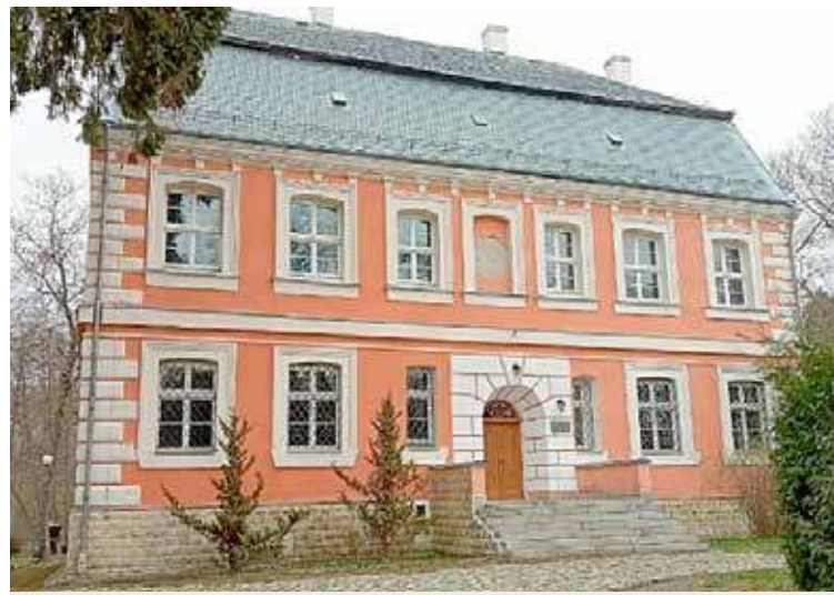
Pałac w Buku przejdzie spory remont
