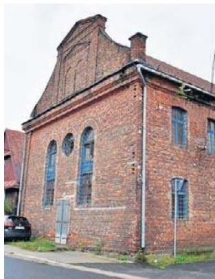
Budynek dawnej synagogi w Czarnym Dunajcu
