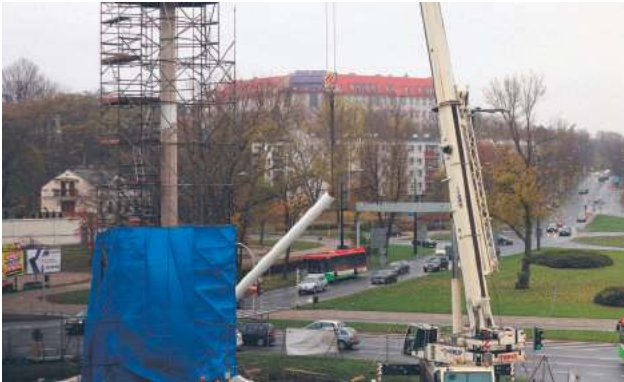
Konstrukcja mającego ważyć ponad 22 tony masztu jest już niemal gotowa. Uroczyste odsłonięcie odbędzie się 11 listopada
