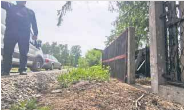
Prace mają zakończyć się do końca października (foto. UM Jaworzno)
