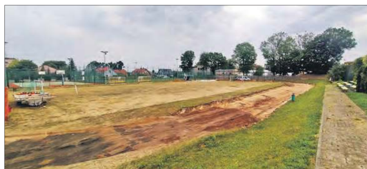
Na kompleksie sportowym przy Starostwie Powiatowym trwają prace ziemne
