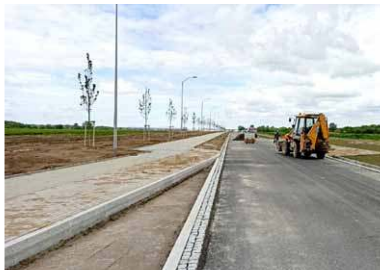
Na ul. Metalowej położono już warstwy podbudowy, a także obrzeża na ciągu pieszo-rowerowym
