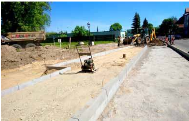
Trwa budowa ścieżki wzdłuż ulicy Spokojnej
