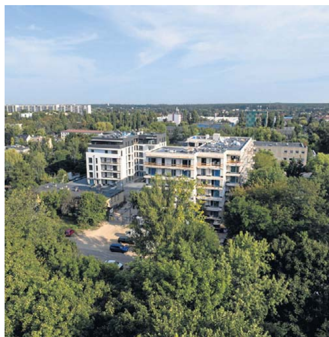
Przy ul. Górniczej 12/14, naprzeciwko Parku im. Szarych Szeregów, powstały dwa budynki pięciopiętrowe – Parkove Love
