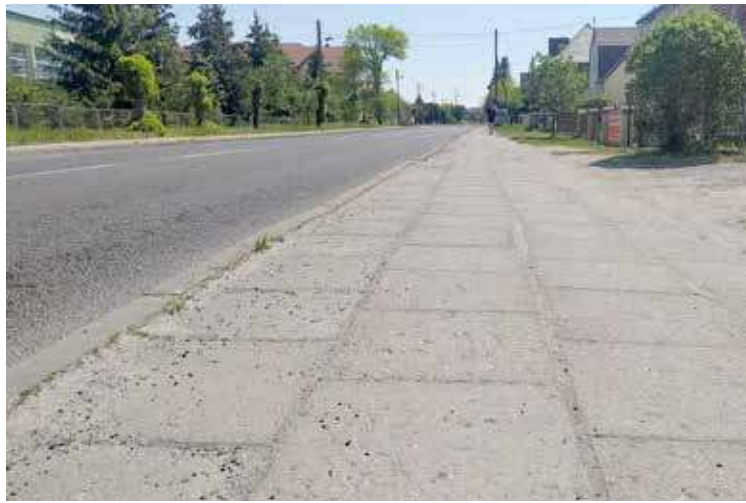
Ciąg dalszy sprawy zabezpieczenia środków na przebudowę 350 metrów chodnika na ul. Księcia Józefa Poniatowskiego będzie miał miejsce na komisji
