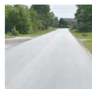
Przebudowa drogi powiatowej w Kotlinach ma zostać wstępnie ukończona do stycznia 2025 r.
