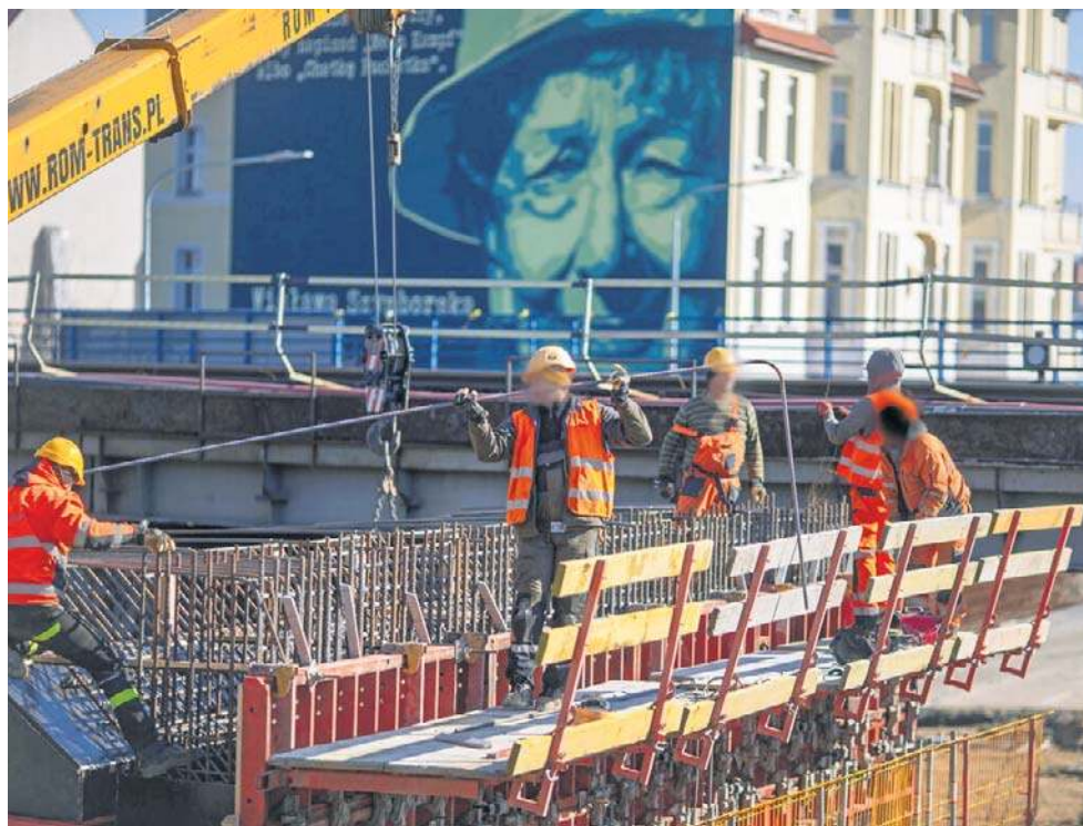
Roboty na wiadukcie kolejowym nad ulicą Szczecińską
