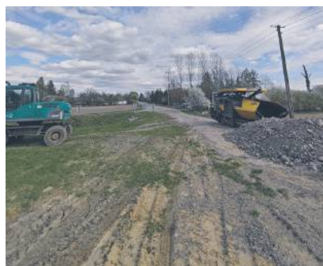
Wola Siennicka - przebudowa drogi -
