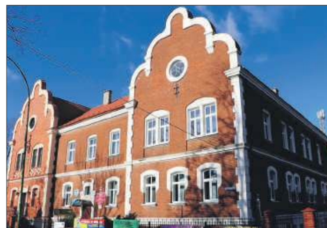
Zabytkowa część dachu na budynku Zespołu Szkół Ekonomicznych w Mielcu zostanie naprawiona.
