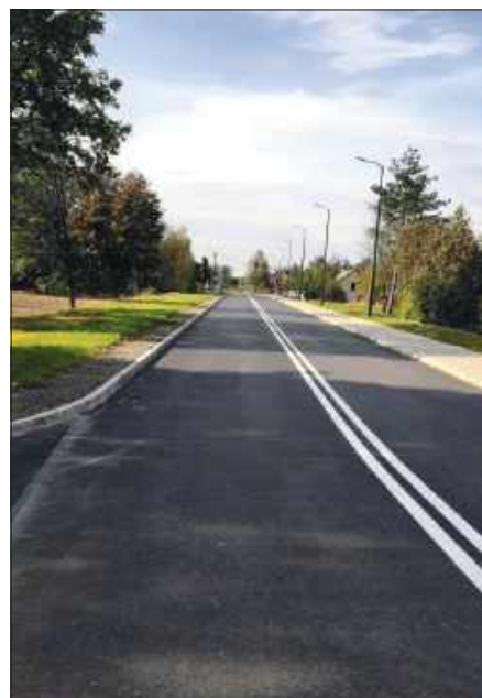
Jedną z zeszłorocznych inwestycji zakończonych przez PZD była kompleksowa modernizacja około 2 km odcinka drogi od skrzyżowania ul. Mszańskiej z Czarnieckiego w Wodzisławiu Śl. do skrzyżowania ul. Turskiej ze Skrzyszowską w Mszanie
