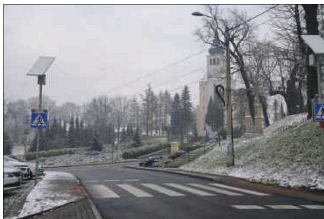
Na początku grudnia zeszłego roku dobiegły końca prace związane z przebudową przejść dla pieszych na ul. Centralnej w Potomi i ul. Wiejskiej w Gogołowej
