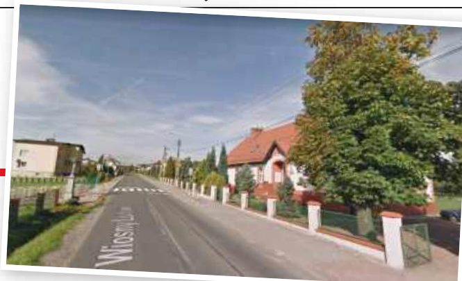
W ciągu ul. Wiosny Ludów w Markłowicach przy Szkole Podstawowej nr 2 powstanie wzbudzona sygnalizacja świetlna. Pod znakiem zapytania stoi jedynie termin realizacji inwestycji.
