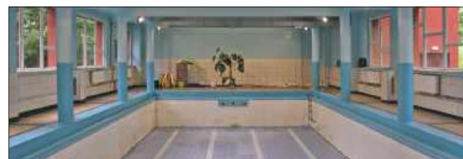
Planowanej modernizacji ma się doczekać niecka basenowa, ma zostać też zastosowana nowa technologia wody basenowej. Ponadto mają zostać zainstalowane sondy i pompy do dozowania chloru, filtry oraz zbiornik wyrównawczy.
