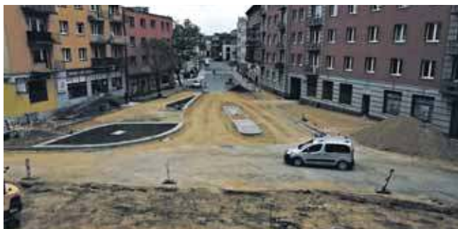
– Termin zakończenia budowy nie jest zagrożony – mówi dyrektor Zarządu Dróg Powiatowych Barbara Myland
