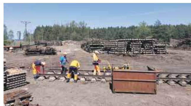
Cieszy również rozpoczęcie prac nad odbudową linii kolejowej 182, która stanowić będzie część metropolitalnego połączenia kolejowego: Katowice – Bytom – Tarnowskie Góry – Pyrzowice
