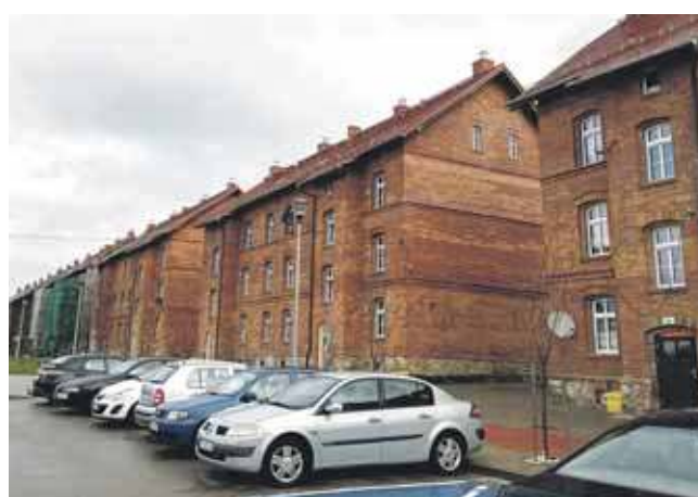
Obecnie trwa piaskowanie elewacji. Część familoków jest już odnowiona
