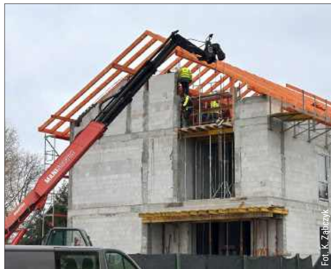
Końcem grudnia odwiedziliśmy plac budowy.
