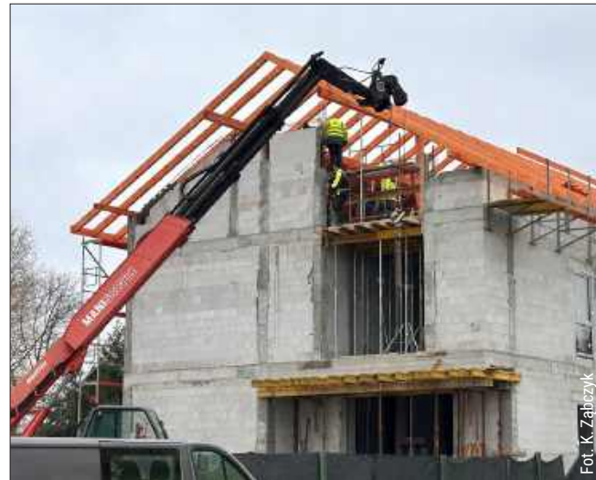
Końcem grudnia odwiedziliśmy plac budowy.
