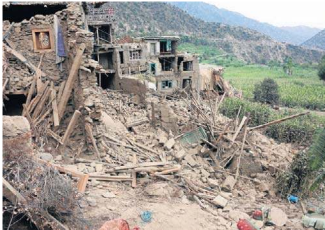
Zniszczeniu uległy m.in. zabytki, a ratownicy przez całą noc walczyli o dotarcie do poszkodowanych
