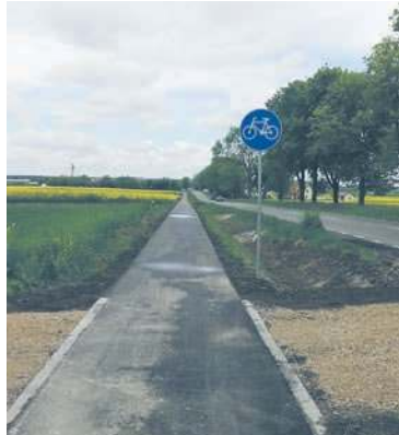
Zakończono budowę ścieżki rowerowej od Chełma do Kamienia
