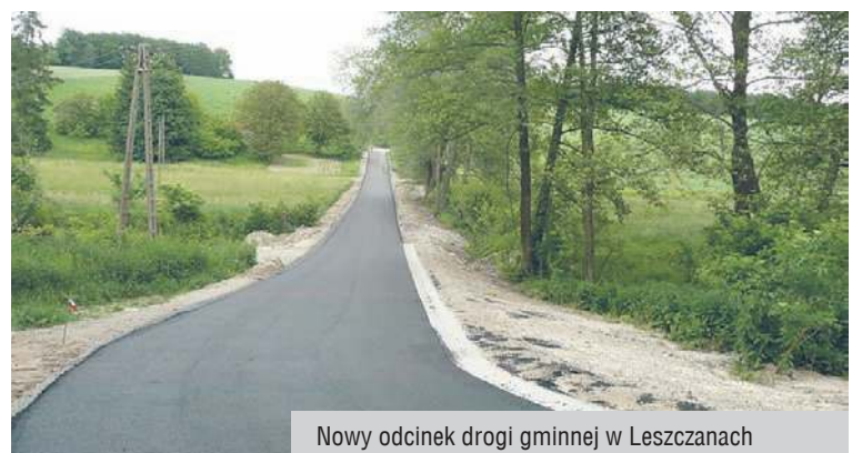
Nowy odcinek drogi gminnej w Leszczanach
