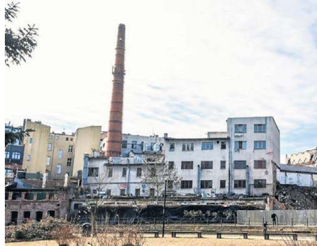
Trwają starania o wpisanie komina do rejestru zabytków województwa kujawsko-pomorskiego
