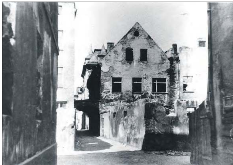
Widok na kamienicę przy ul. Sobieskiego od zaplecza. To w wyniku prac rozbiórkowych usunięto jeden z łuków nad ul. Tkacką.
