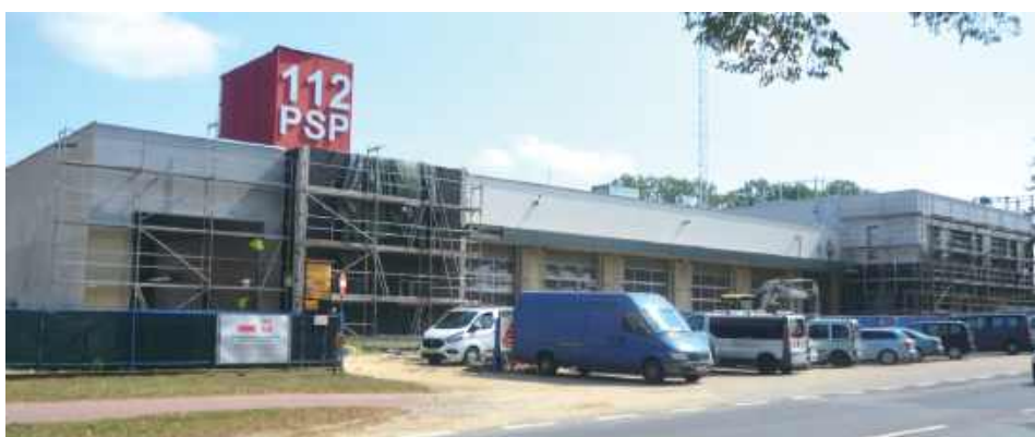
Prace przy budowie nowej komendy dla druhów rozpoczęły się w 2022 r. Otwarcie zaplanowano na pierwszy kwartał 2025 r.
