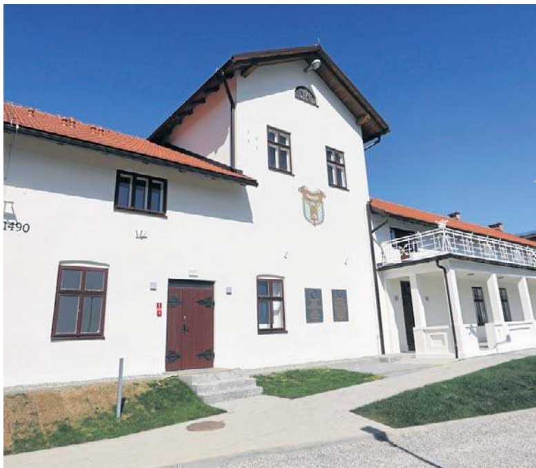
Obiektowi groziło wyburzenie. Ostatecznie udało się przeprowadzić remont. 29 sierpnia Dom Ludowy został ponownie otwarty
