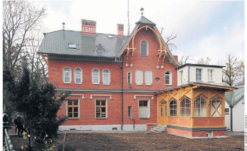
Remont willi rozpoczął się w październiku 2024 r. Całkowity koszt sięga 6,5 mln zł (z czego 2,7 mln zł dofinansowanie)
