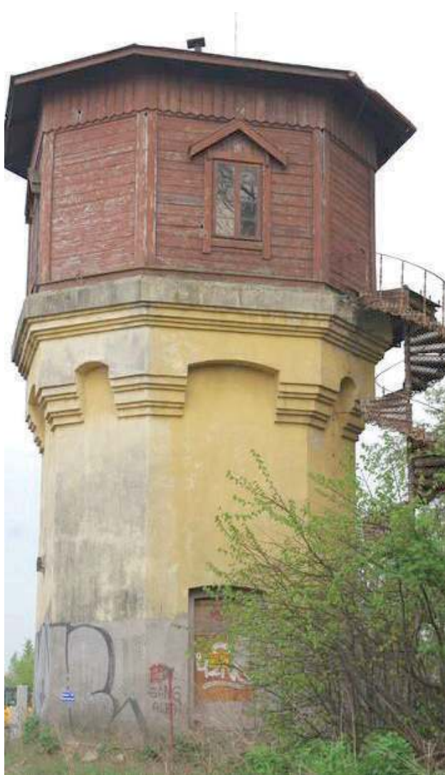
Dolna część wieży zbudowana została z cegły palonej, druga kondygnacja jest drewniana
