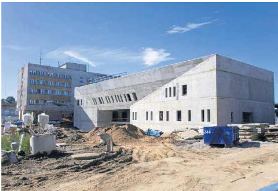
Budowa nowego dworca kolejowego w Słupsku
