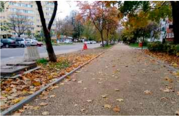
Drogowcy już zrobili podbudowę pod nową ścieżkę pieszo-rowerową
