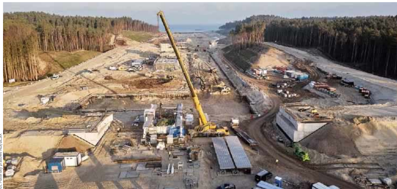
Budowa kanału żeglugowego przez Mierzeję Wiślaną
