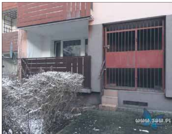
Schodki przy balkonie
