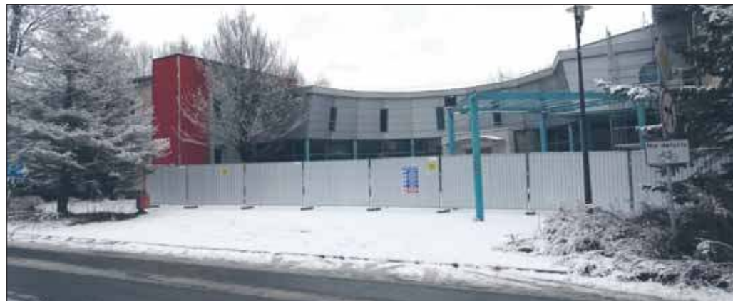
Remont przyszłego budynku Akademii WSB
