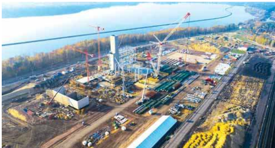
Nowo budowany blok gazowo-parowy w Rybniku
