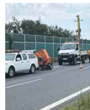
Zanim dojdzie do remontu, pobierane są próbki podłoża
