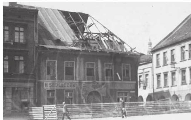
Tak wyglądała winiarnia Sedlaczka 15 lipca 1954 r. podczas remontu dachu
