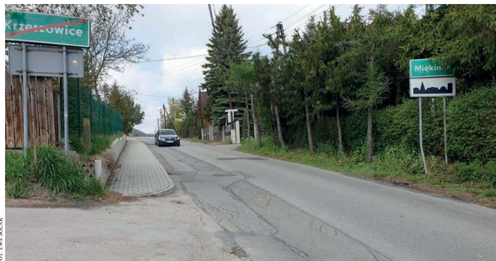
Drogę do Miękini czeka gruntowna przebudowa
