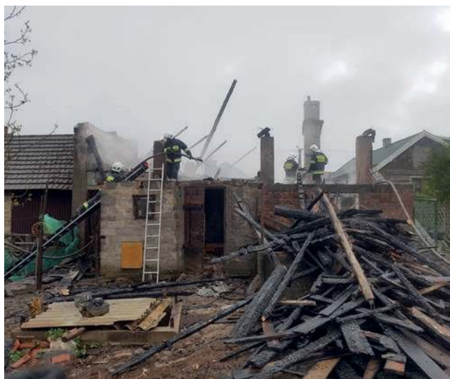
Tak wyglądało pogorzelisko po pożarze domku gospodarczego w Lgocie. Strażacy pomagali zabezpieczyć obiekt. Potem mieszkańcy zorganizowali zbiórkę na rzecz pogorzalców
