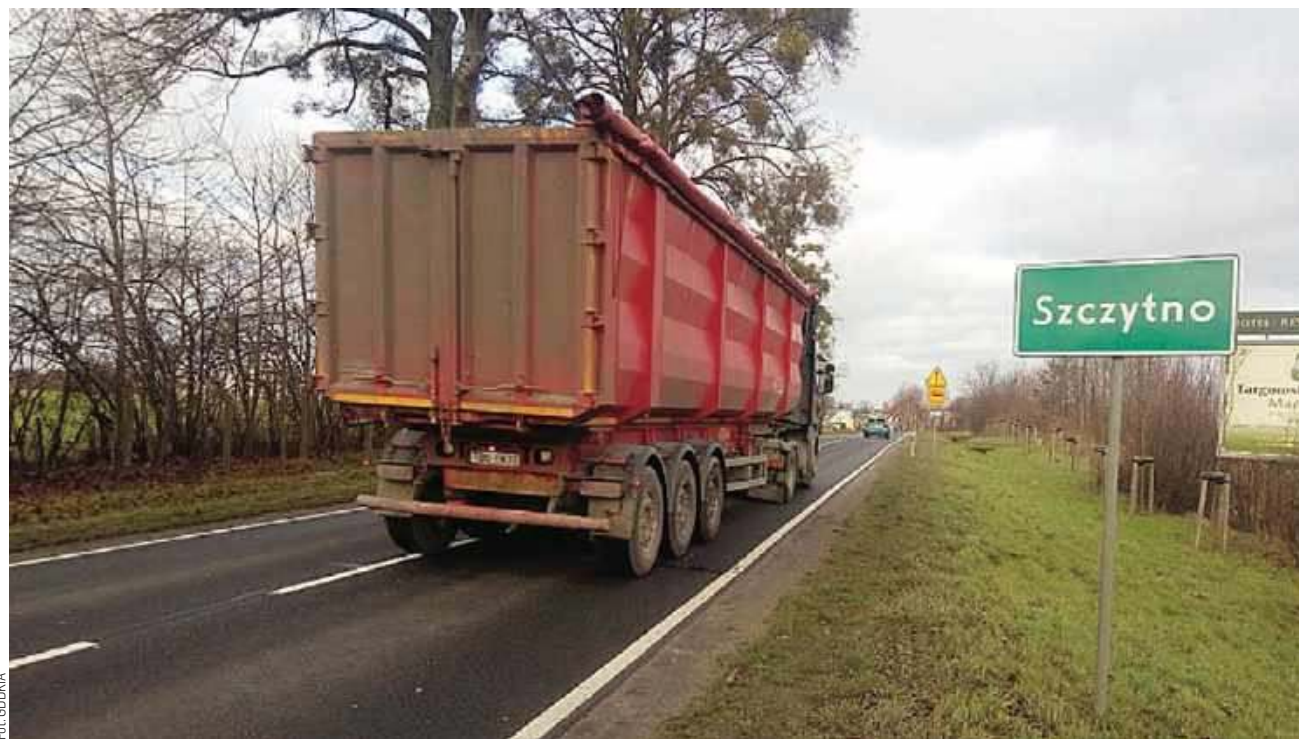
Obwodnica Szczytna ma powstać w latach 2026 - 2028
