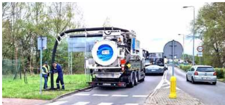
Prawownicy GWiK oczyszczalni kanalizację deszczową (fot. Gm. Goleniów)
