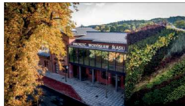
Mimo że półtora roku temu zakończono generalną przebudowę budynku wodzisławskiego dworca kolejowego za wiele milionów złotych, potrzebne są kolejne prace remontowe związane z jego odwodnieniem
