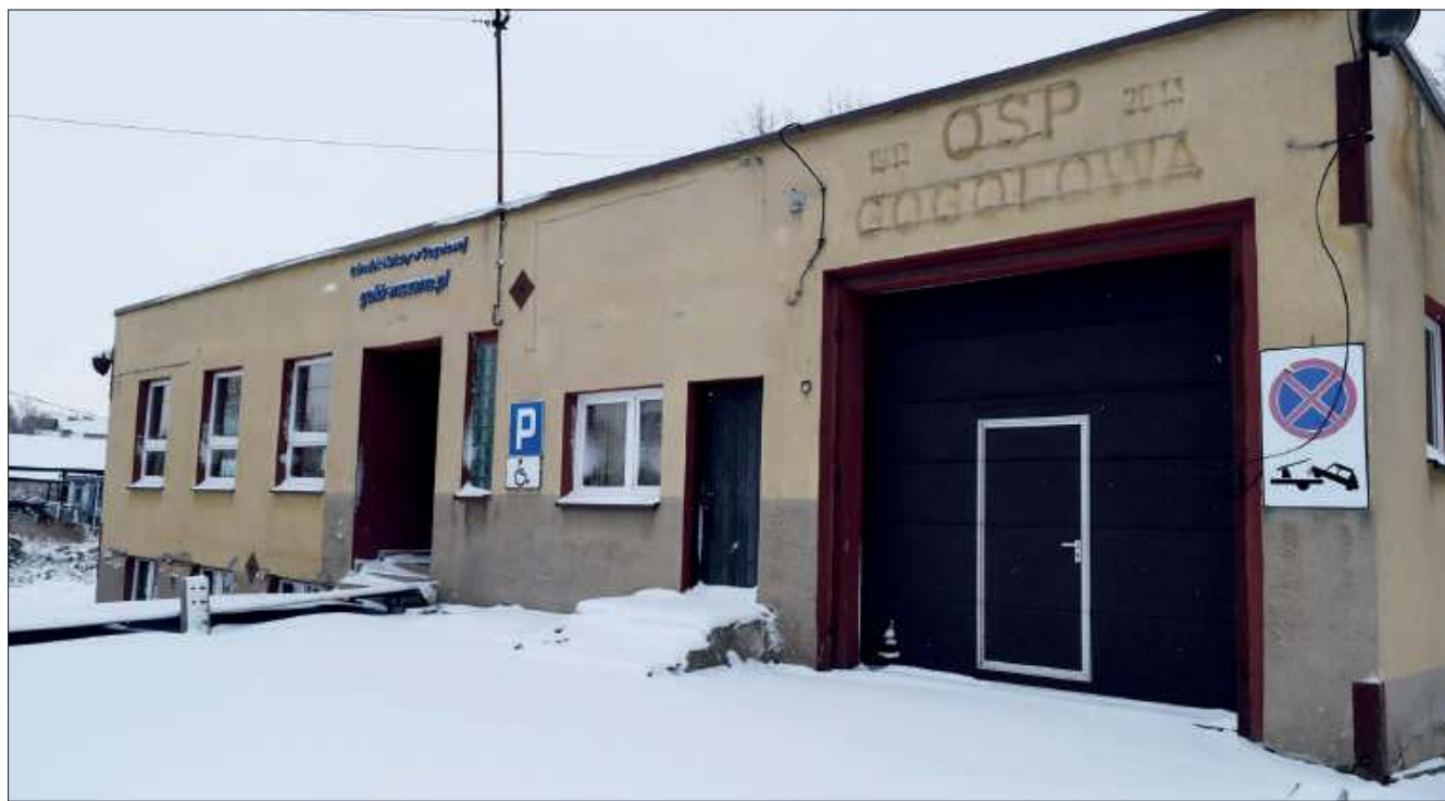
OSP Gogołowa wyniosła się już ze swojej starej siedziby, która lada moment zostanie wyburzona
