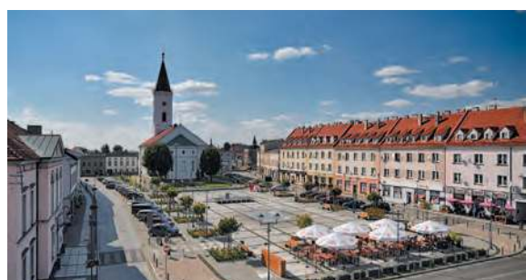
Rewitalizacja miasta Dobrodzień - przebudowa placu rynku.
