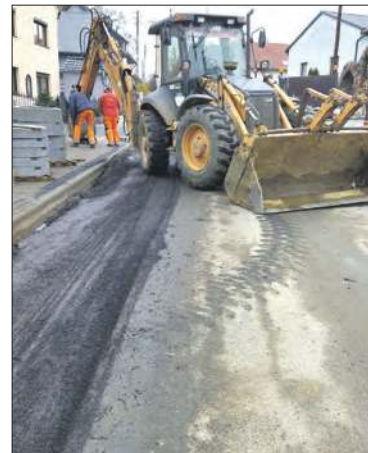
Prace przy gminnej drodze w Prężynie
