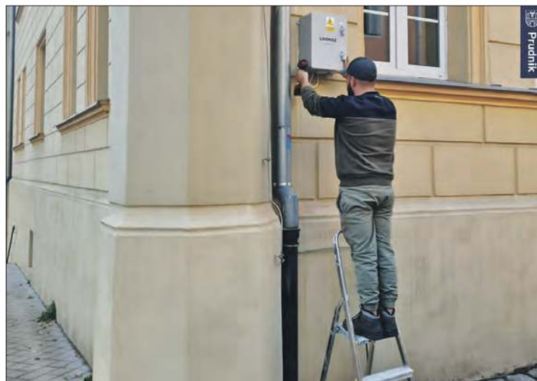
Czujnik Looko2 zamontowany został w centrum miasta, co oznacza, że będzie „zbierał” dane z obszaru, gdzie jest wiele mieszkań opalanych starymi piecami węglowymi. Urządzenie podaje również temperaturę i wilgotność powietrza.
