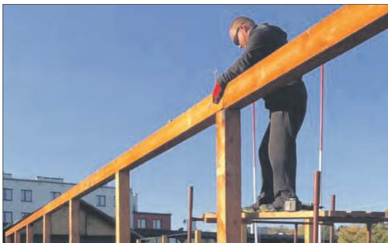
Trwa odbudowa wiaty
