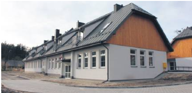
Niedawno zakończyła się rozbudowa i przebudowa budynku dawnej przychodni rehabilitacyjnej.
