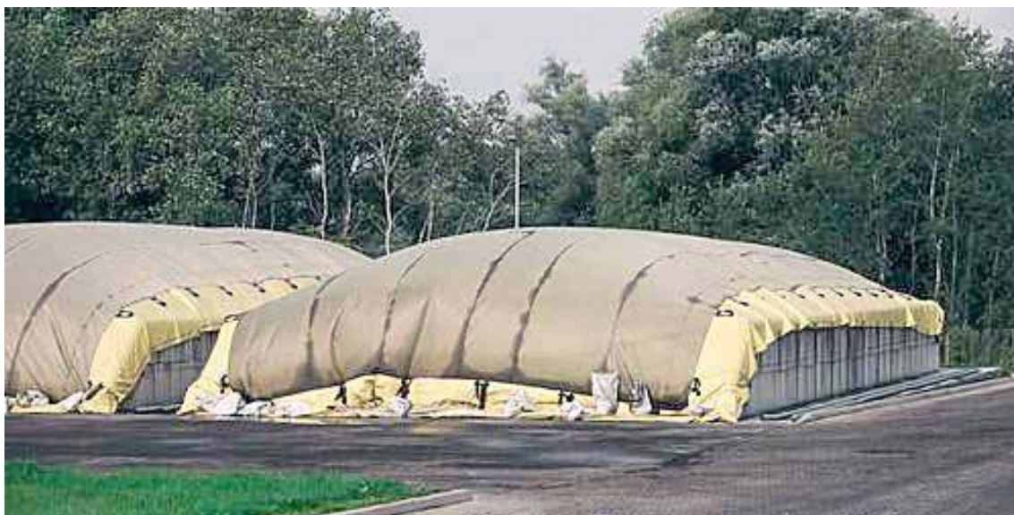
Nowoczesna kompostownia na terenie GWiK
