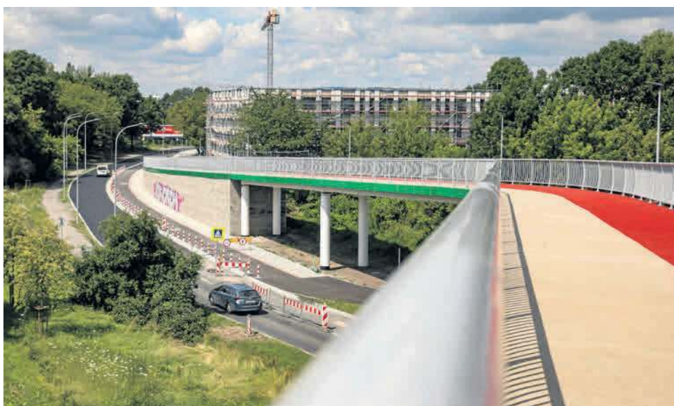
Nowa kładka rowerowa wzdłuż ulicy Kamieńskiego
