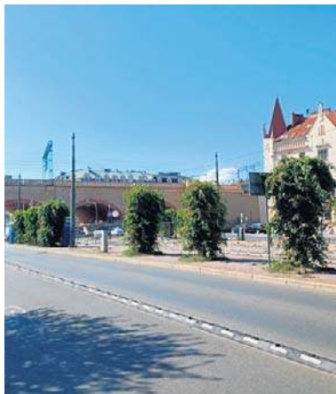
Postępują prace związane z modernizacją torowiska
