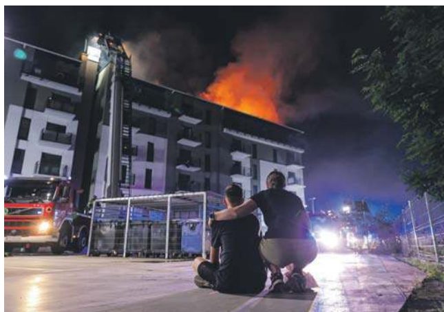
Pożar strawił dach i najwyższe piętro bloku przy ulicy Krańcowej. Akcja strażaków trwała wiele godzin
