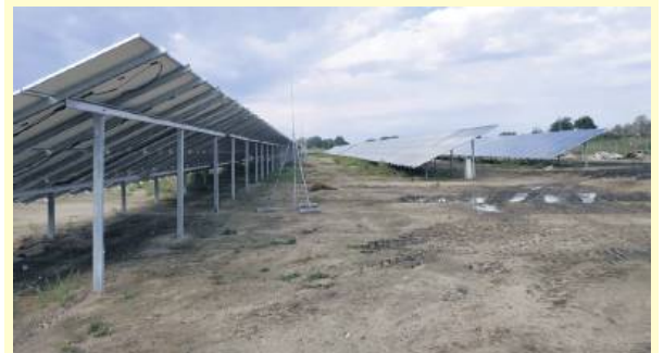
W Muchowcu na terenie dawnej oczyszczalni ścieków postawiono około 6000 paneli fotowoltaicznych o mocy prawie 3 MW. Obecnie trwają tam prace porządkowe. Fot. UMiG Strzelin
