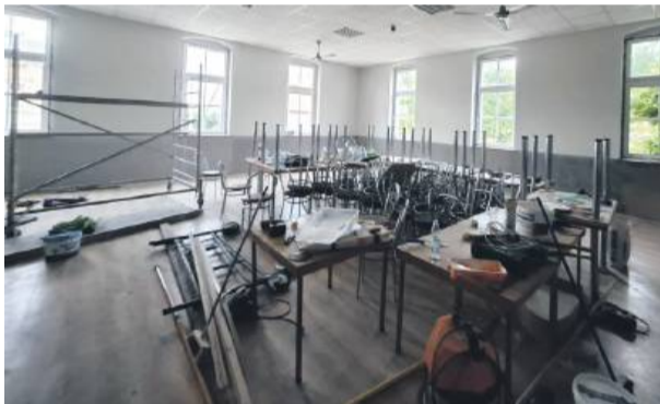
W świetlicy wiejskiej w Witowicach trwa obecnie remont sali głównej oraz korytarza i kuchni
