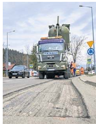
Frezowanie asfaltu powoduje utrudnienia w ruchu
