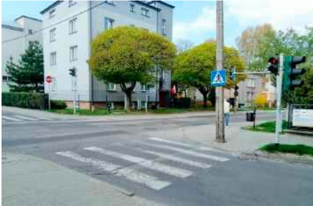
Z oszczędności na realizacji projektu pn. „Przebudowa strategicznego korytarza transportu zbiorowego wraz z zakupem taboru w centralnej części obszaru LOF”, w ramach którego modernizowano Al. Raclawickie i ul. Lipową, przebudowane zostanie skrzyżowanie ul. Popiełuszki z ul. Głowackiego
