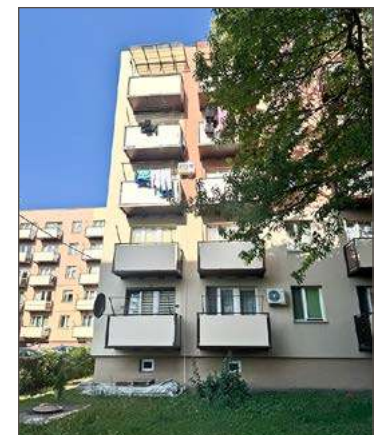
Na bloku przy Łysogórskiej 19 balkony już zamontowane.
