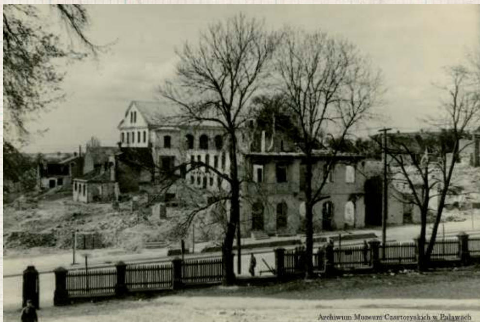
Zbudowana w XIX wieku synagoga w Puławach, dziś na jej miejscu (okolicie ulicy Piłsudskiego) znajduje się głaz z pamiątkową tablicą. Niemcy zniszczyli ją w czasie II wojny światowej, a niemal wszystkich z 3600 Żydów z Puław zamordowali na miejscu, bądź wywieźli do obozów zagłady. Fotografia z zasobu Pracowni Dokumentacji Dziejów Miasta Muzeum Czarzyńskich, przekazana przez pana Krzysztofa Przygodzkiego, opublikowana na profilu FB
