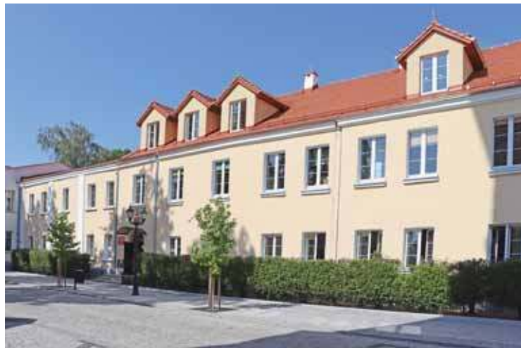
Budynek ZS im. B. Prusa z nowym dachem i po remoncie elewacji pld. (od strony dzwonnicy)
