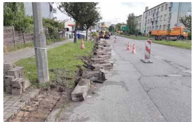
Wymiana krawężników na ul. Grzebskiego
